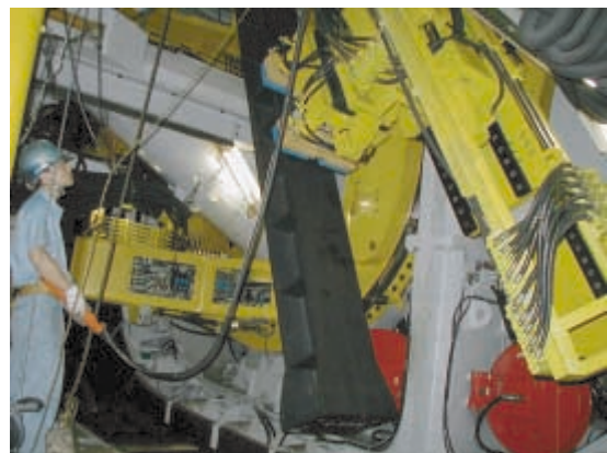
図21 セグメントの組立試験 (図24の手順11に相当)
