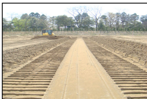
図 14 情報化施工による整地精度と施工面
