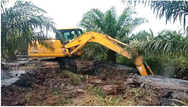
図19a 実稼働の様子（水路整備）
