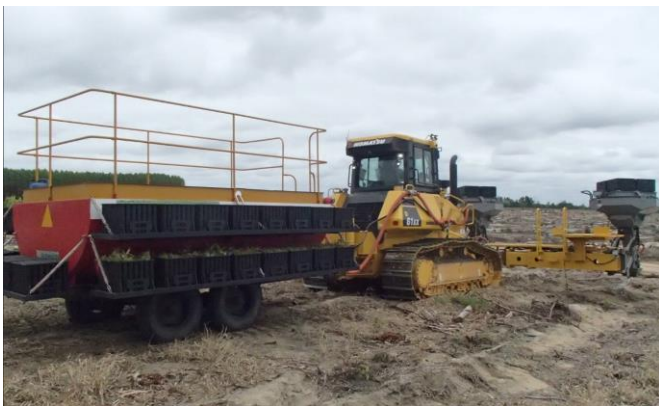
図8 タンカートレーラの例
