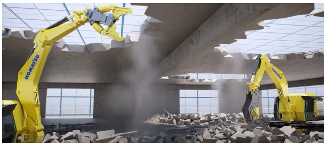
図11 屋内解体現場での活用例 (CG)
