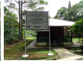
植林地内管理棟
