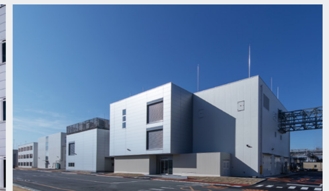
第3実験棟(小山工場内)
