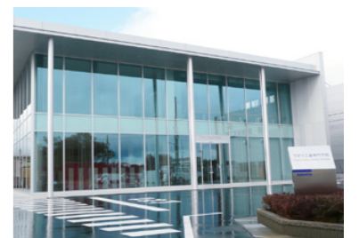
粟津工場内に新設したコマツ工専の研修棟
