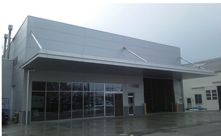
バイオマス発電建屋
